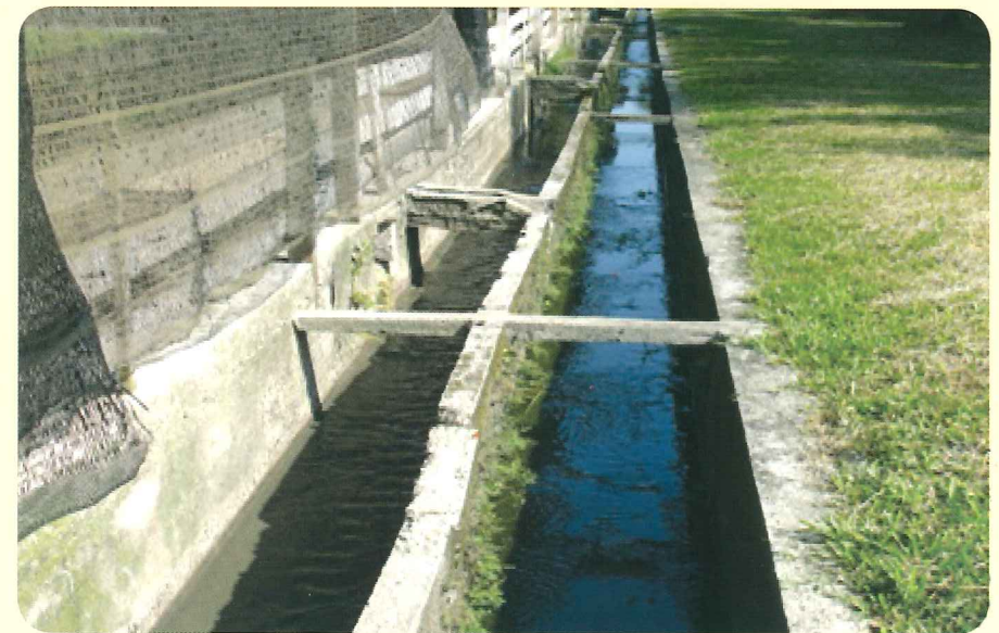
Pengasingan Sistem Peparitan Efluen Dan Air Hujan
